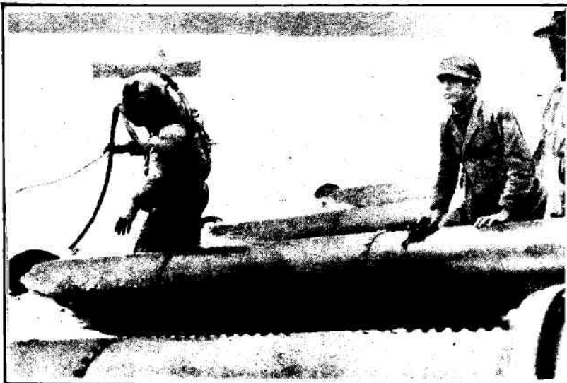
Uno de los buzos que trabajan en las obras de desecación del Lago Nemi. En primer término se ven los enormes tubos de las poderosas bombas que evacuan el agua del lago.
